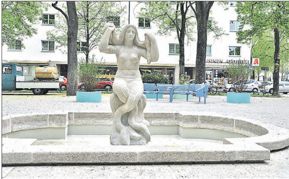
Der sanierte Brunnen ist das Wahrzeichen des Karl-Preis-Platzes.
